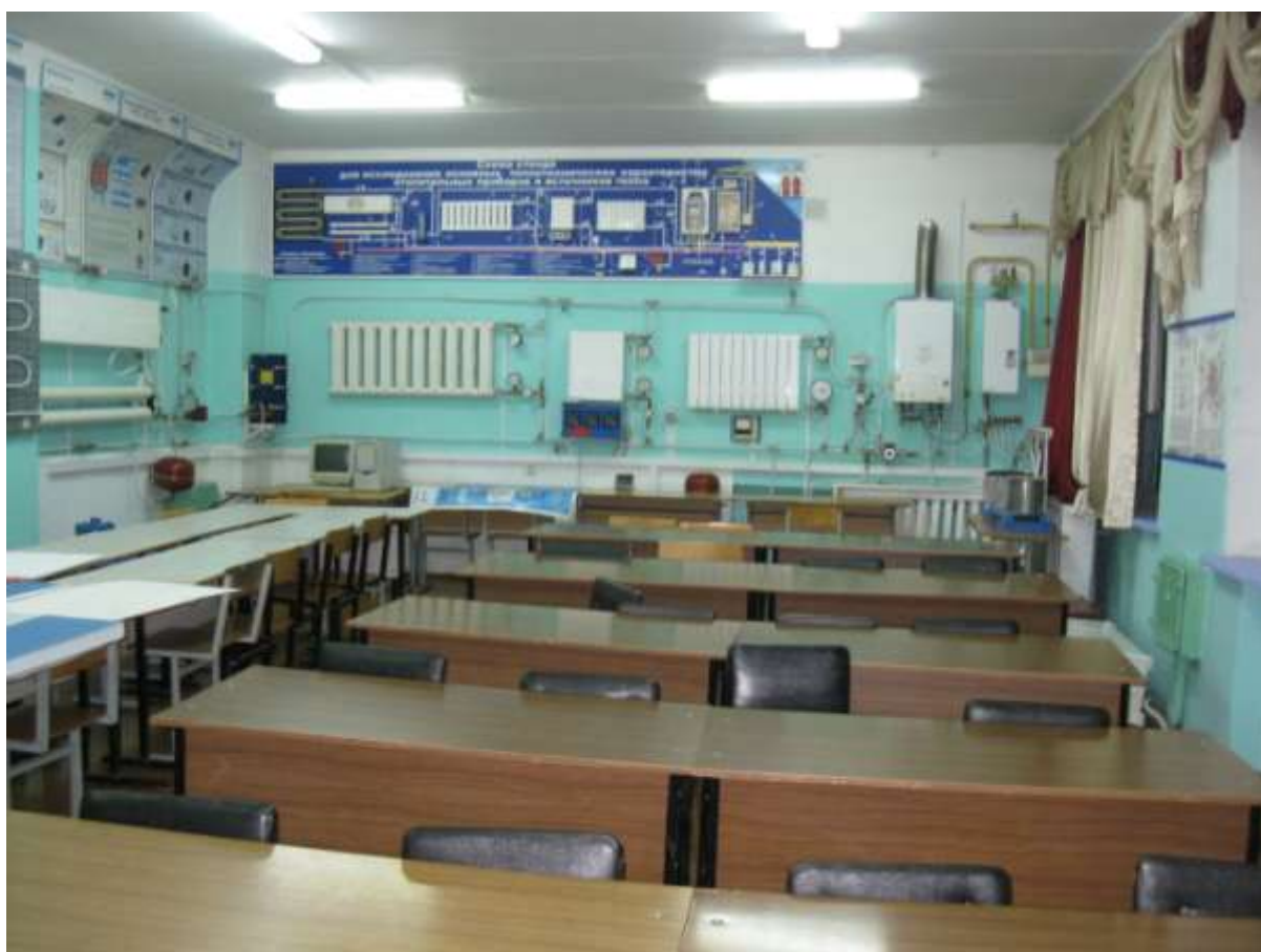
Лаборатория гидродинамики и тепло- газоснабжения
